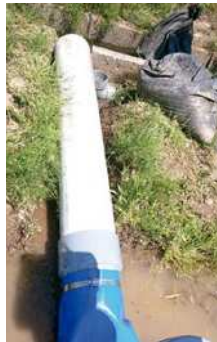
写真3. オープン水路で塩ビ管を埋設した事例
