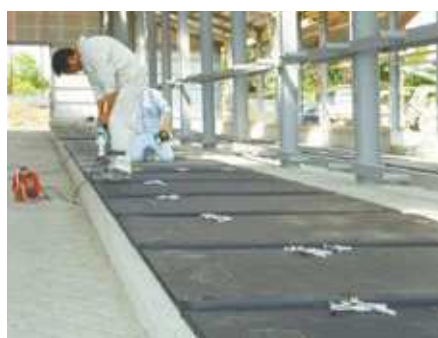
写真 3. ボビレックス設置の作業風景
